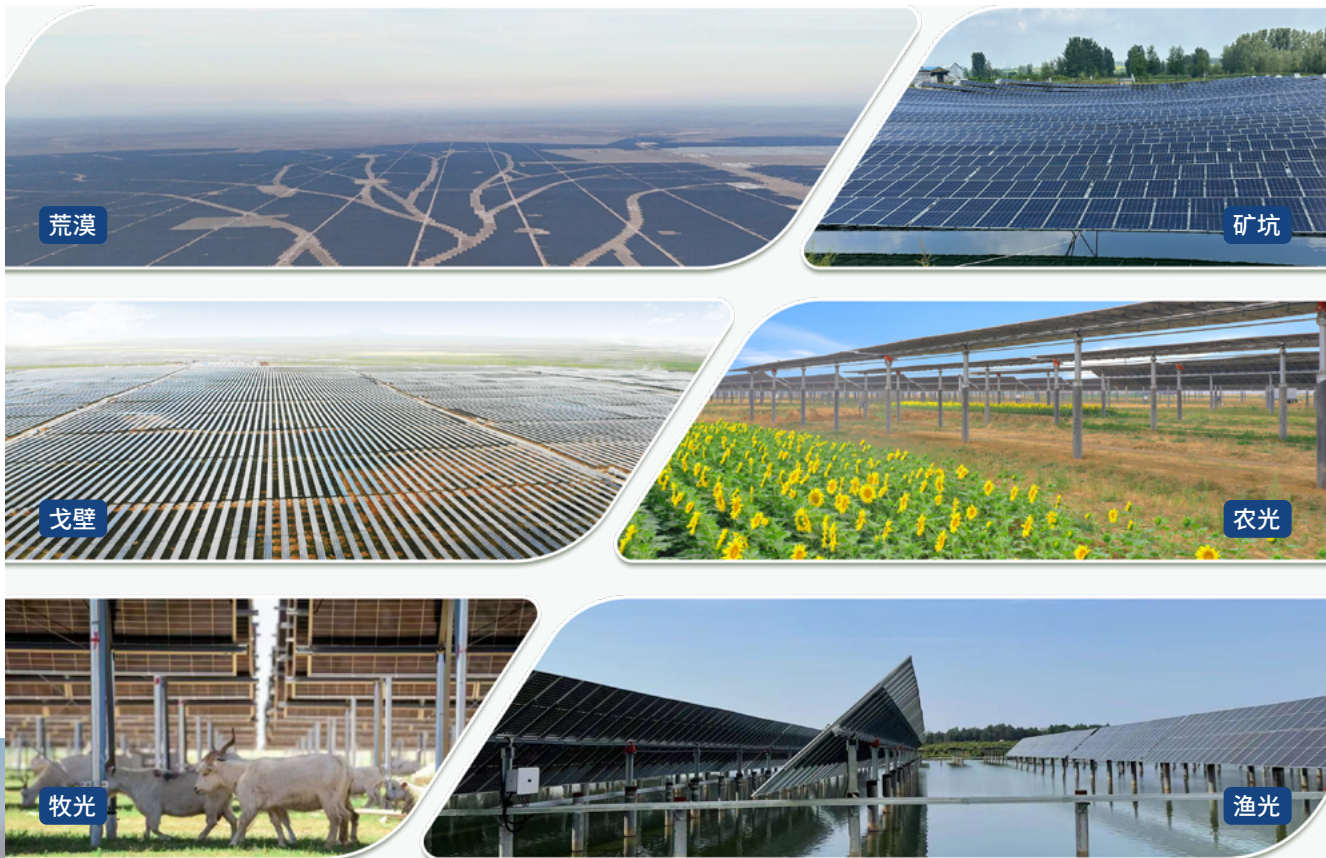
公司适配光伏全场景生态治理应用
