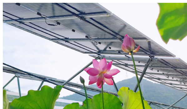
三门核电支持三核村开展“渔光互补”光伏项目
