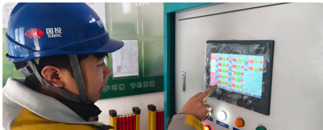
国投小三峡加强污水处理设备管理
