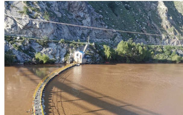
国投小三峡投入 130 万元，清理三站河面漂浮物，累计清理漂浮物 14071 立方米，清理物均进行合规处置
