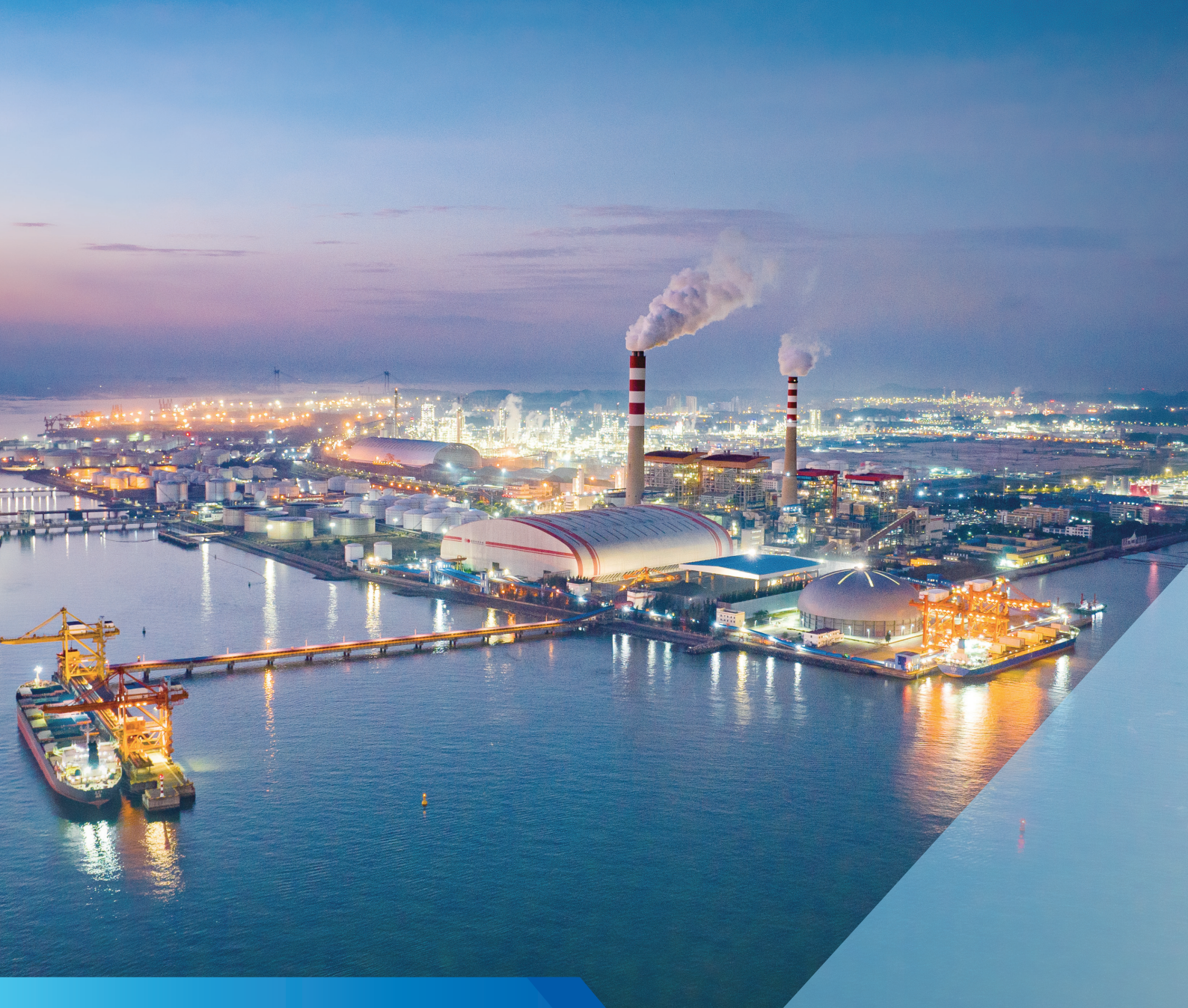
国投钦州电厂
