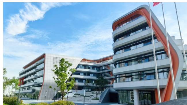
盛和资源控股股份有限公司总部大楼
