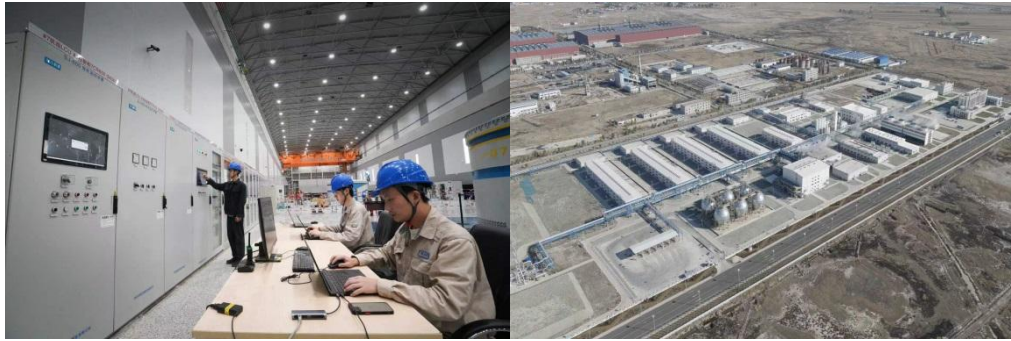
(支撑南方电网梅州抽蓄电站投运)
