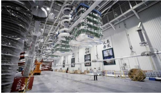
(渝北±800 千伏换流站项目现场)
