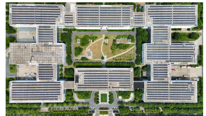
产业园一期光伏电站技术改造后俯瞰图
