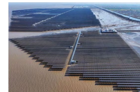
国华如东光氢储一体化光伏场区全览图
