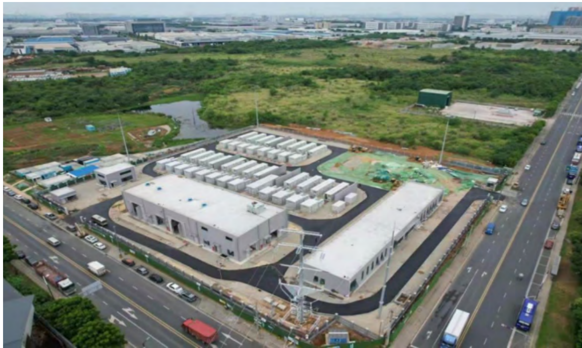
四川省电网侧首个组串式储能项目
