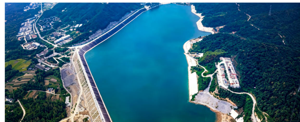
江苏句容抽水蓄能电站
