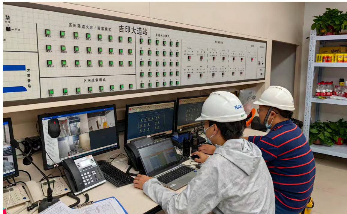
南瑞工控技术人员在吉印大道项目现场进行系统调试
