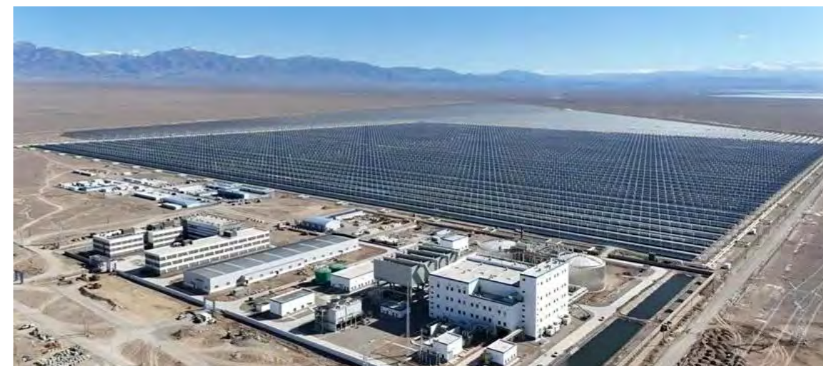
三峡能源新疆哈密综合能源示范项目现场
