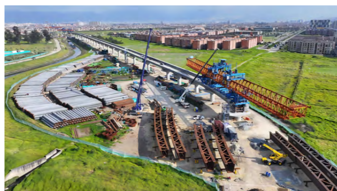
哥伦比亚波哥大地铁 1 号线项目 Bogotá Metro Line 1 Project, Colombia
