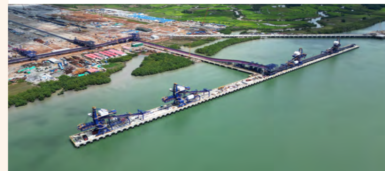
马瑞巴港矿石码头项目 Marampa Ore Terminal Project
