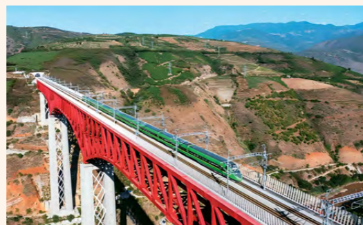
中老铁路项目 China-Laos Railway Project
