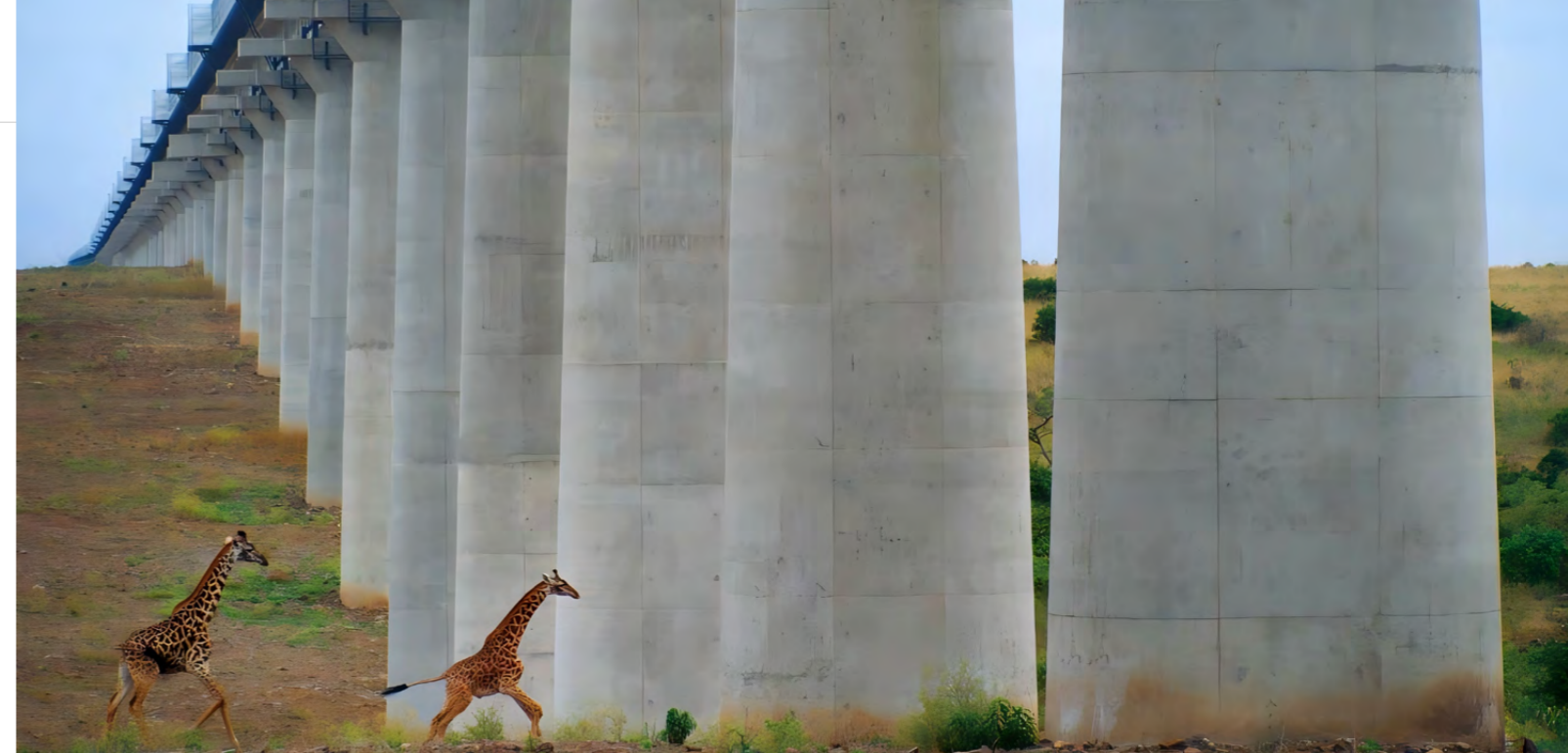
符合动物安全通行设计的蒙内铁路内罗毕国家公园特大桥项目
