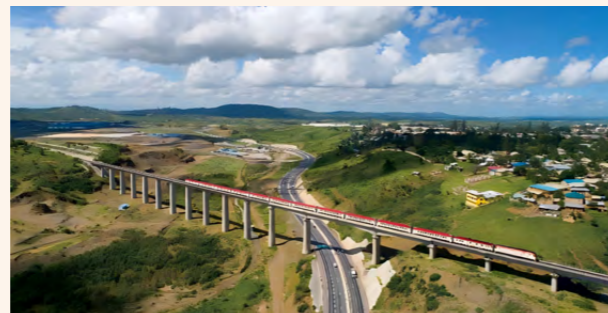
肯尼亚蒙内铁路项目 Kenya Mombasa-Nairobi Railway Project
