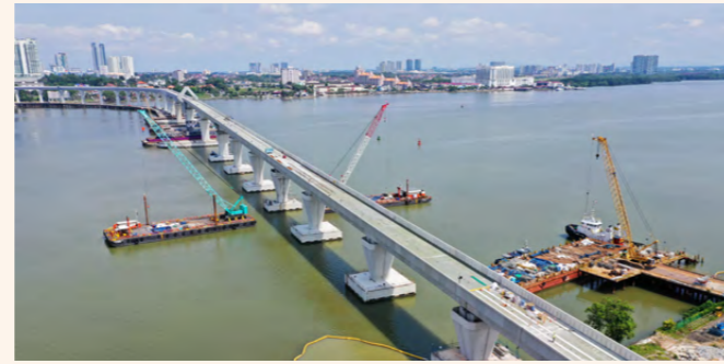
新加坡新柔捷运 T235 项目 Singapore Jurong-Johor T235 MRT Project
