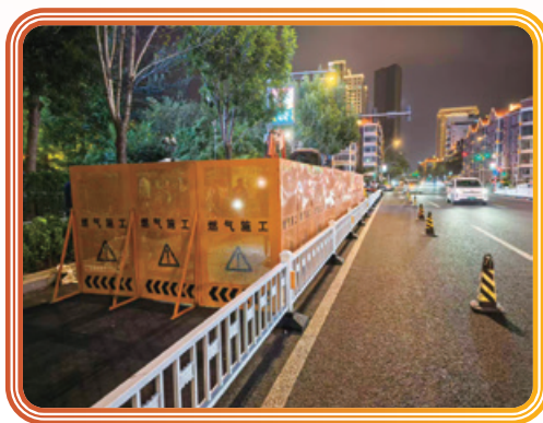
圖：匯川路景蓬道燃氣支線漏氣應急搶修現場
