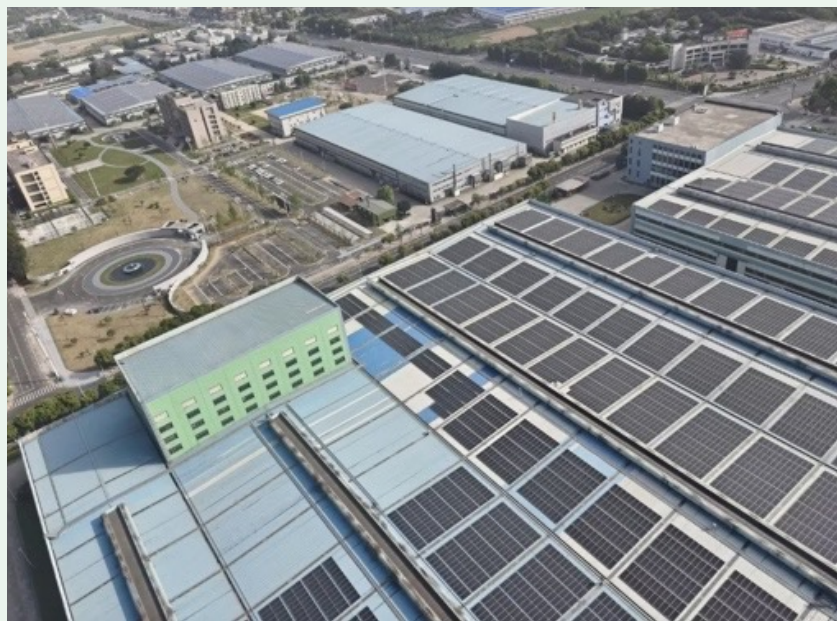
厂房光伏设备俯瞰图
