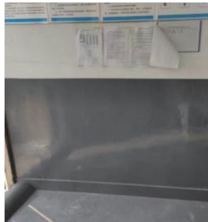
危险废弃物暂存间 地面防渗防腐措施
