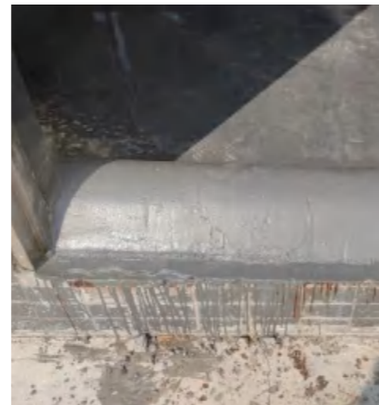
危险废弃物暂存间门口 围堰设置情况
