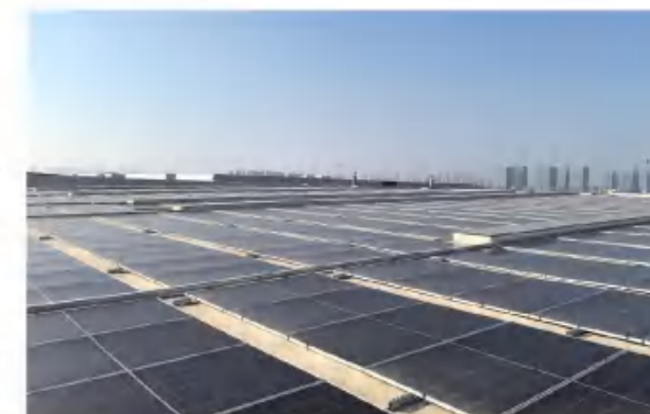
新建光伏发电
