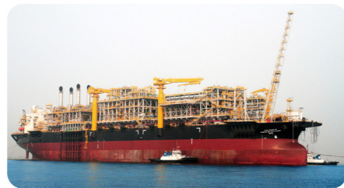
浮式生产储卸油船改装
