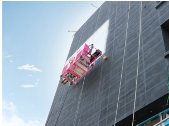
外墙喷涂机器人施工
