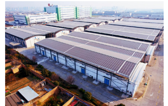
陕西兴平产业园清洁能源光伏发电项目
