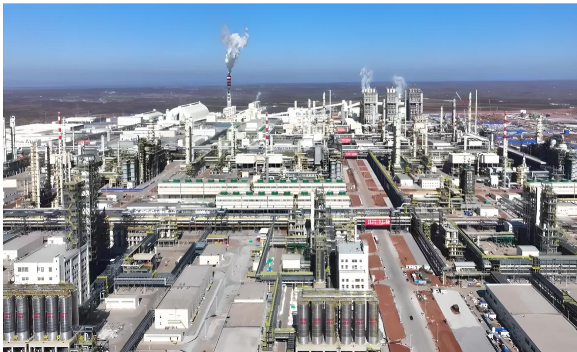
内蒙古宝丰煤基新材料 4×100 万吨/年煤制烯烃项目一期 260 万吨/年煤制烯烃和配套 40 万吨/年植入绿氢耦合制烯烃项目分离装置（化工建设工程质量评价 5A 优质精品工程）
