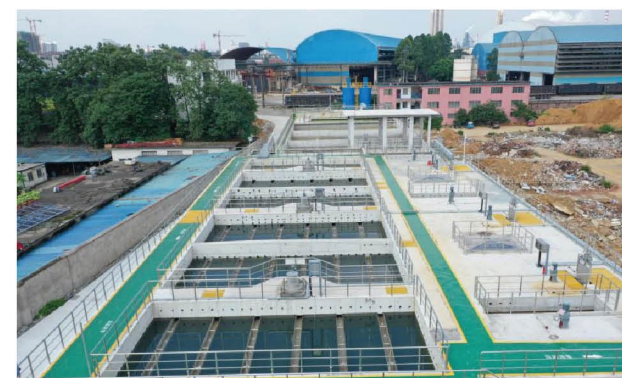
3# 废水处理站二期工程
