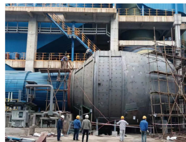
增压风机出口安装矩阵式排风消音器
