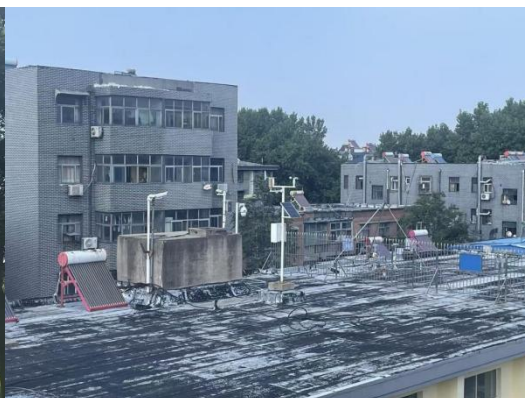
图 2：项目现场调研时期的照片（大气监测设备）
