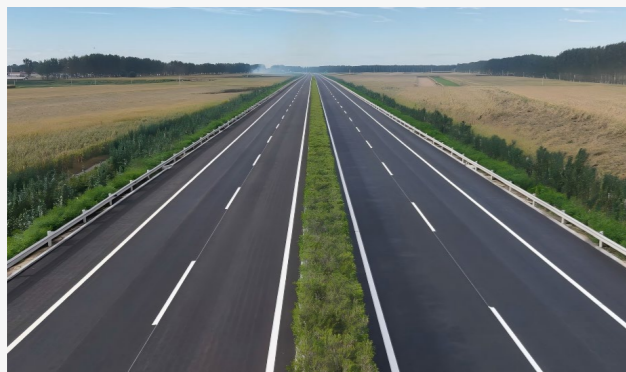
辽宁交投养护基地的沥青路面工程
