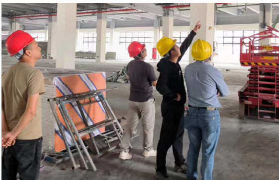
施工现场安全检查
