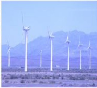
塔城发电 风力发电厂
