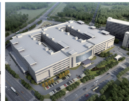
厦门产业基地
