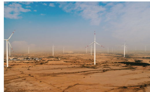
UEPW 99 MW 風電項目
