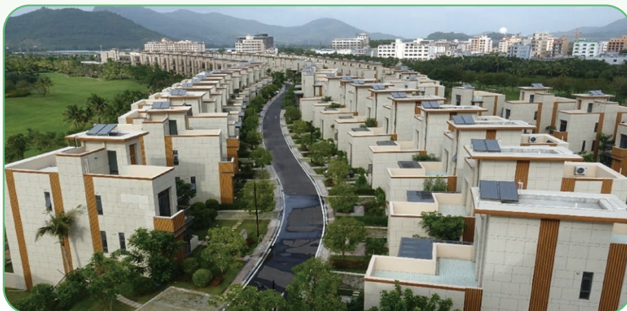
海南清水灣3號安裝太陽能系統
