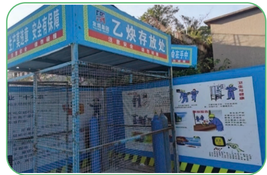
易燃、可燃材料堆放區域
