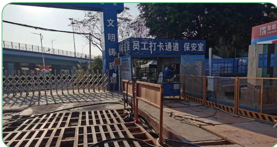
工地出入口實名制管控
