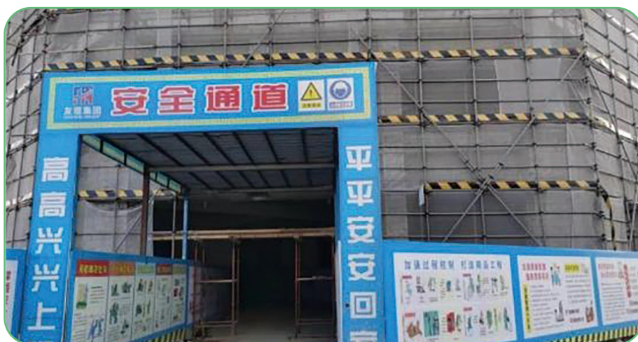
施工安全通道
