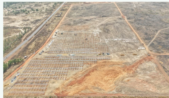
馬利光儲一體電站施工現場
