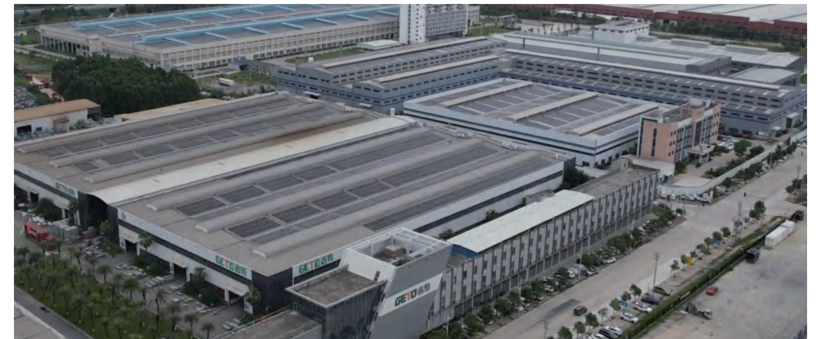
江门志特工厂屋顶光伏发电
