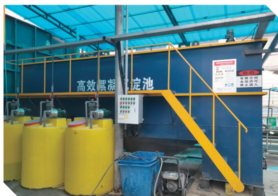
圖註：河南公司新增一體化高效沉澱池提升廢水治理效果
