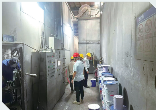
圖註：消防安全檢查現場
