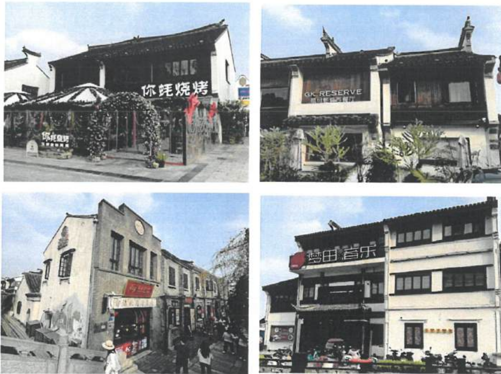
图一：现场勘察照片
