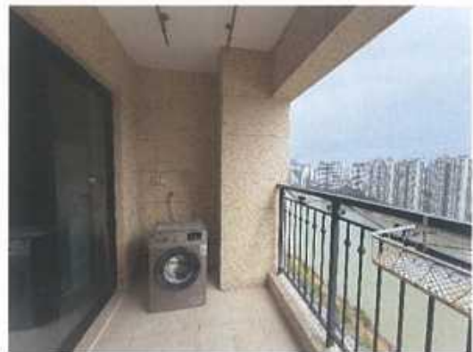
估价对象内部
