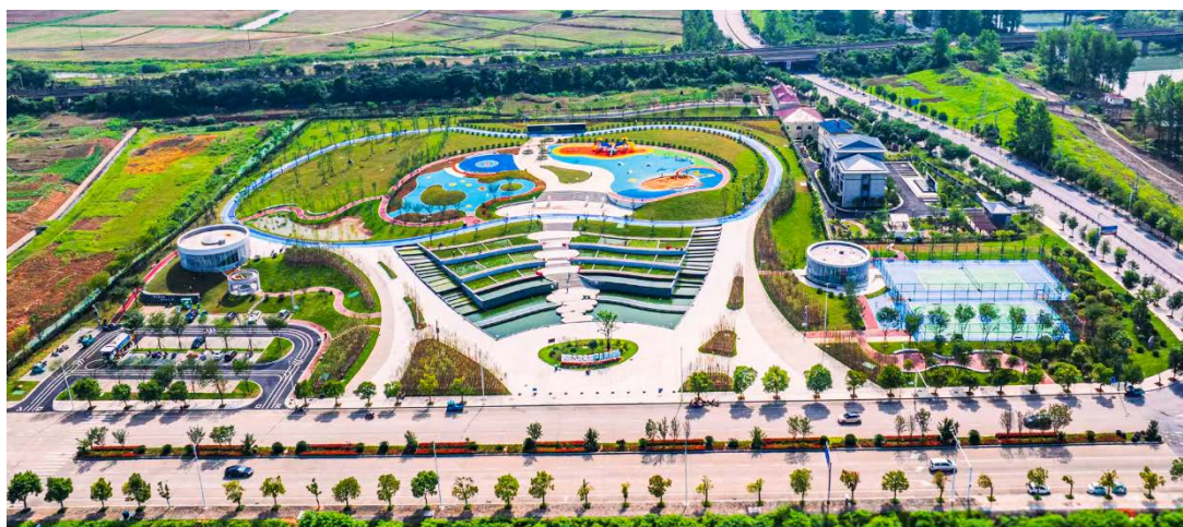
瑞昌市城西污水处理厂全景（3万吨/日）
