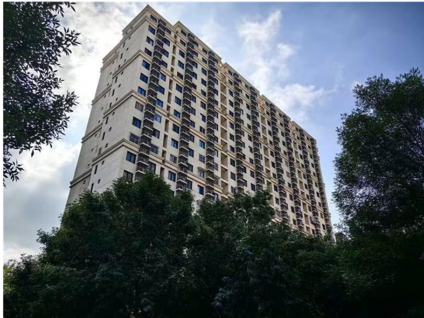
图 盛悦家园项目实景图
