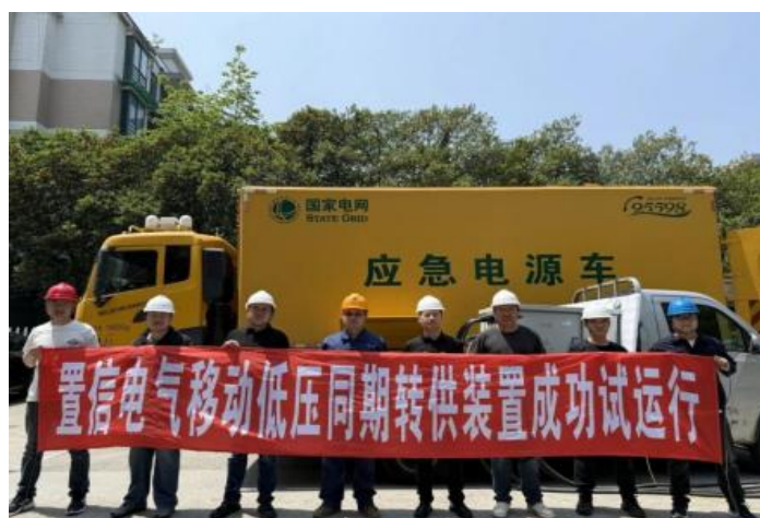
图：置信电气低压同期转供装置成功试运行
