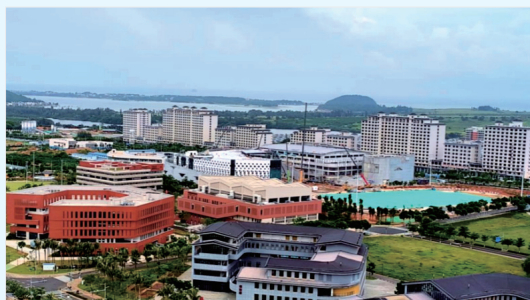
▲ 陵水黎安国际教育创新试验区光储充一体化项目
