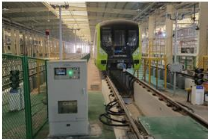
可视化接地验电装置和防误系统
