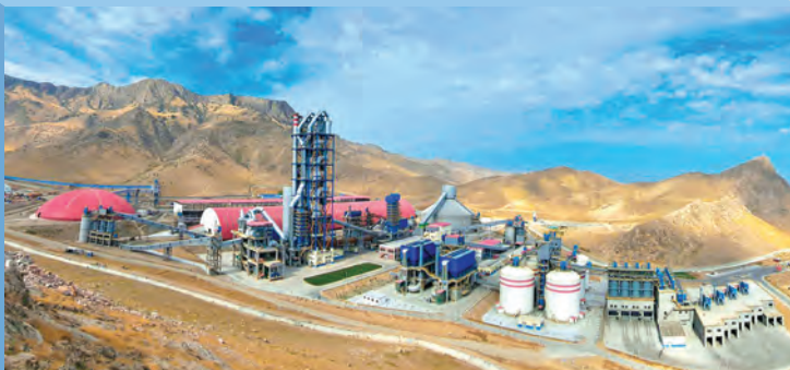
安集延西部水泥廠房，烏茲別克斯坦
