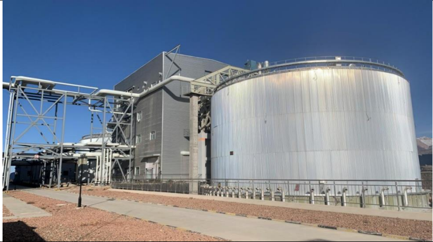
图表 16 青海中控德令哈 50MW 光热电站熔盐储能系统
