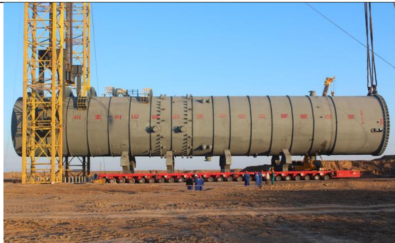
图表 20 费托合成反应器
