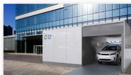
协鑫能科单通道换电站
