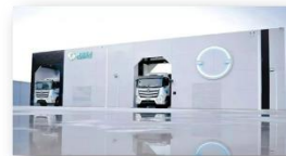
商用车双通道换电站
