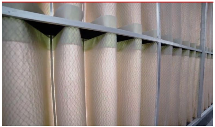
图 21 猪舍空气过滤装置
