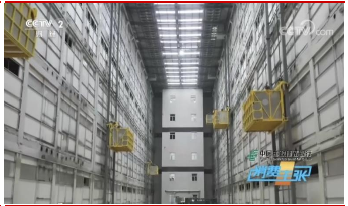
图 2 楼层之间由电梯转运猪只
