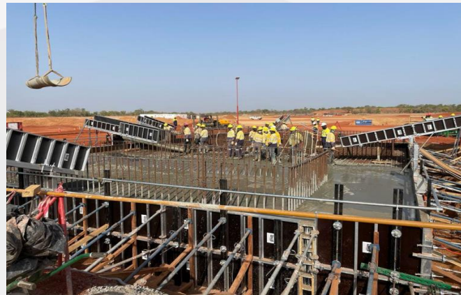
图28：白班浇筑球磨机筏板
