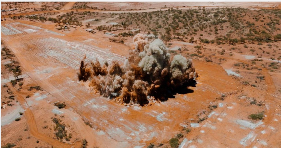
图11：Mt Mann 露天矿第一次爆破的鸟瞰图
