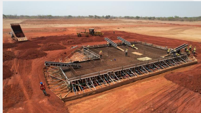
图27：球磨机筏板准备工作
