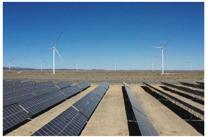
图4: 甘肃首个风光储一体化项目——安北风光储一体化项目
