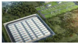
用户侧储能解决方案 面向工厂、商业场所
