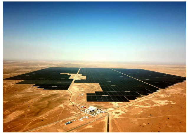
图 51：阿曼伊卜里光伏项目
