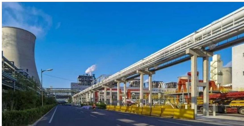
图25 鲁西化工 220kV GIL 采用高空敷设降低隧道建造成本
