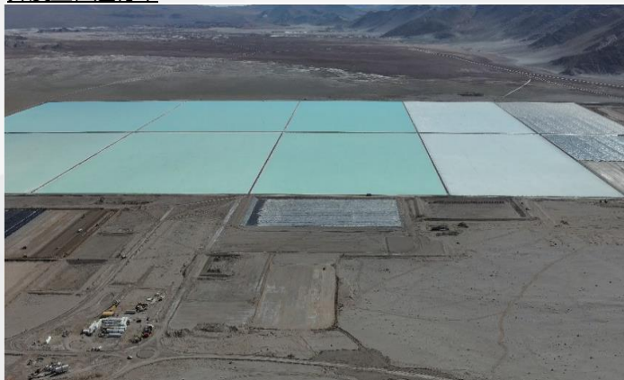
图2：Sal de Vida一期：前两组盐田已完成90%，碳酸锂工厂的开发正在进行中
