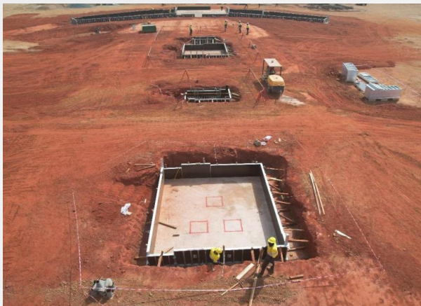
图52：2023Q1浇筑的初级破碎机和输送机混凝土
