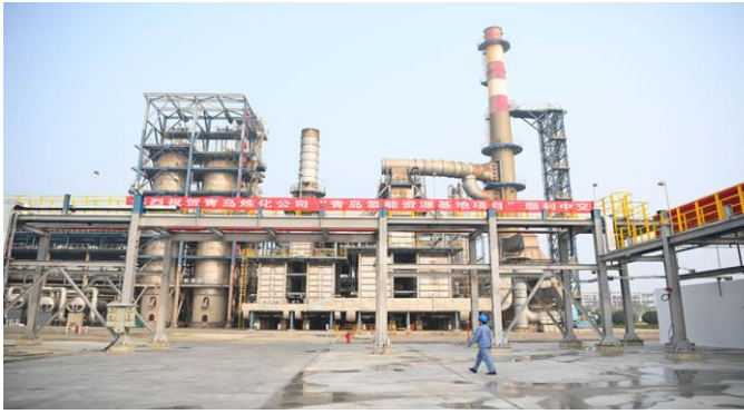
图 34：青岛炼化氢能资源基地项目
