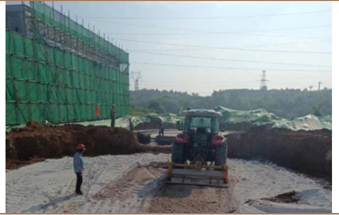
图 35：齐鲁氢能一期氢能一体化项目施工现场
