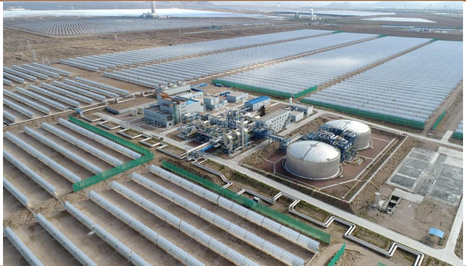
图 43：中广核德令哈 50MW 槽式光热电站
