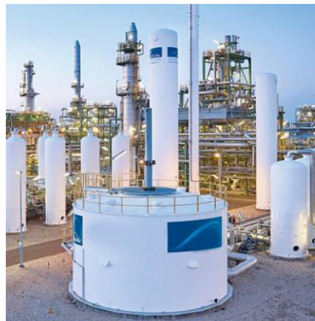
卧式液氢储罐
