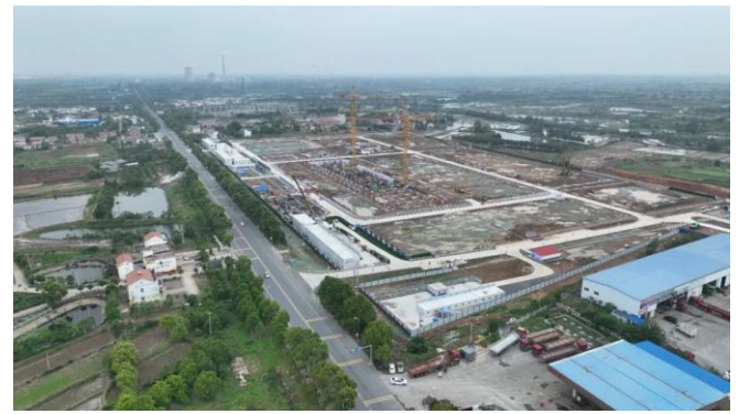
图33 湖北应城300兆瓦级压缩空气储能电站示范工程
