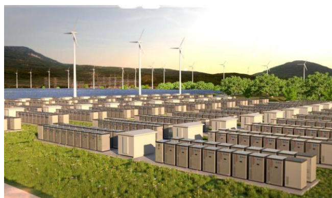
图54 梅州五华电网侧独立储能项目
