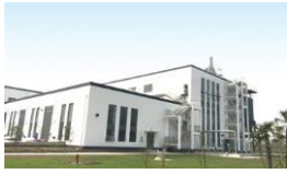
扬州污泥处置和资源化利用项目
