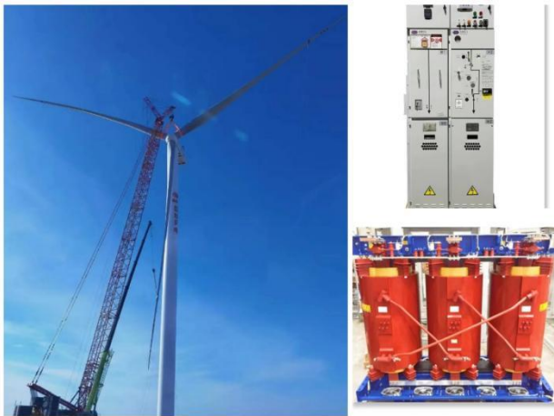
图 24: 国投甘肃新能源北七风电 B 区 200MW 项目
