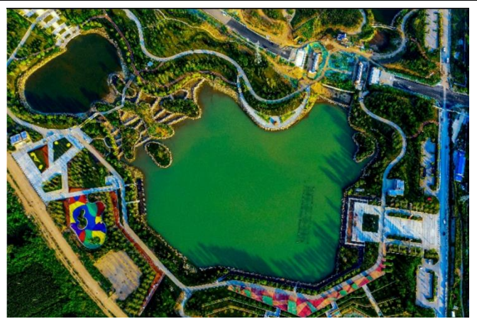
图15：渭南创新湖景区工程
