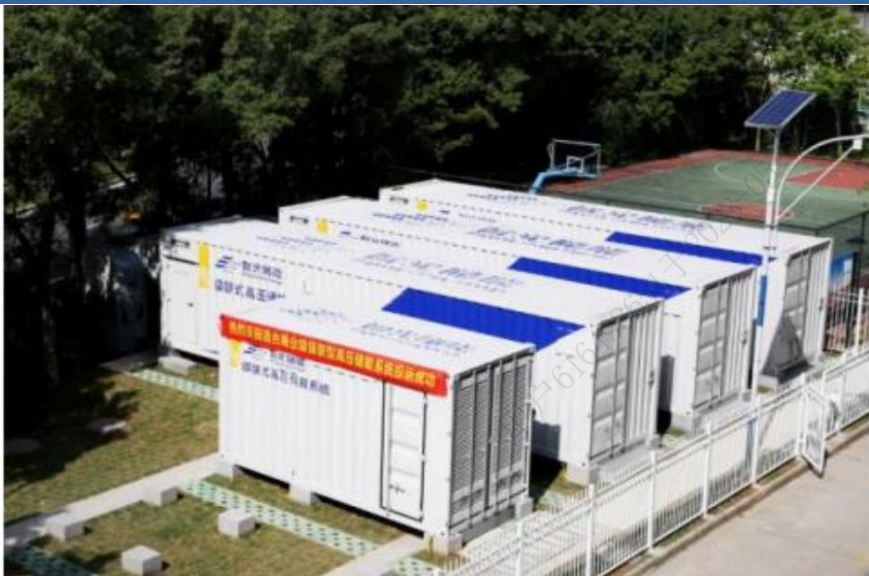
图：公司首台商业级 5MW/3MWh 高压级联储能系统
